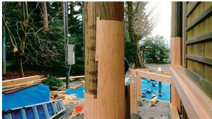
金輪継手工法での修復例
